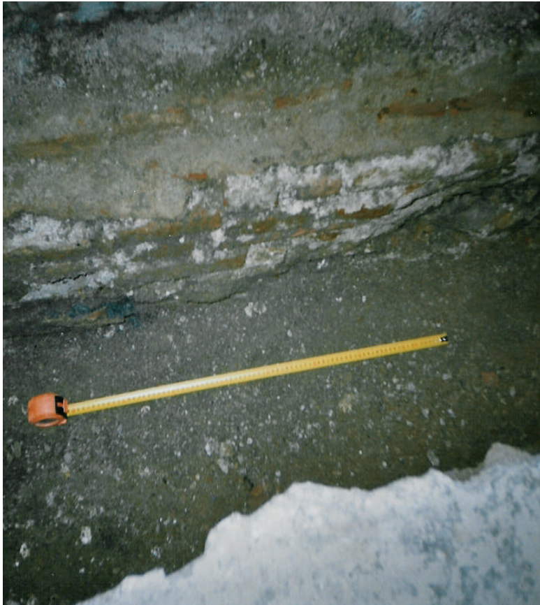
F. 5. Tram de claveguera –UE 1003- documentat a la rasa 2000.
